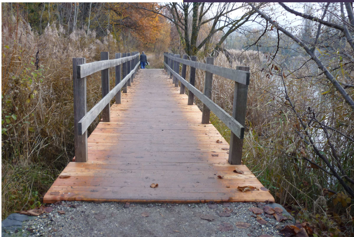
Photo de la passerelle rénovée Henri Mabillard
