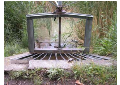
3. Vanne pour régler le niveau du lac
