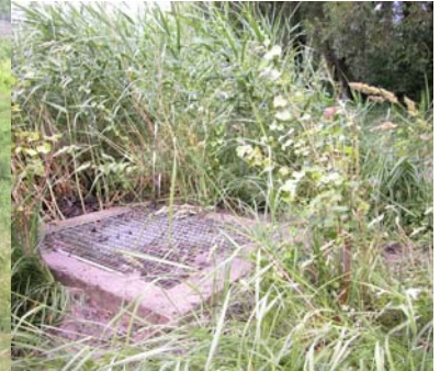
2. Un des déversoirs après la chambre de décantation
