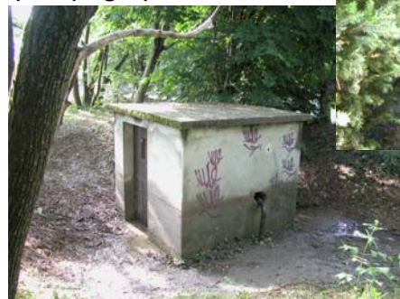
6. Ancienne station de pompage privée
