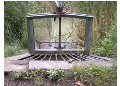
3. Vanne pour régler le niveau du lac
