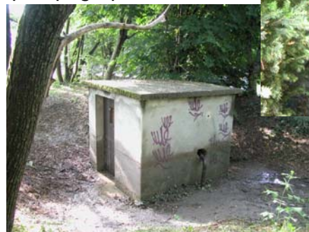
6. Ancienne station de pompage privée
